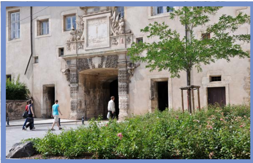
Porte de la Citadelle Gate
